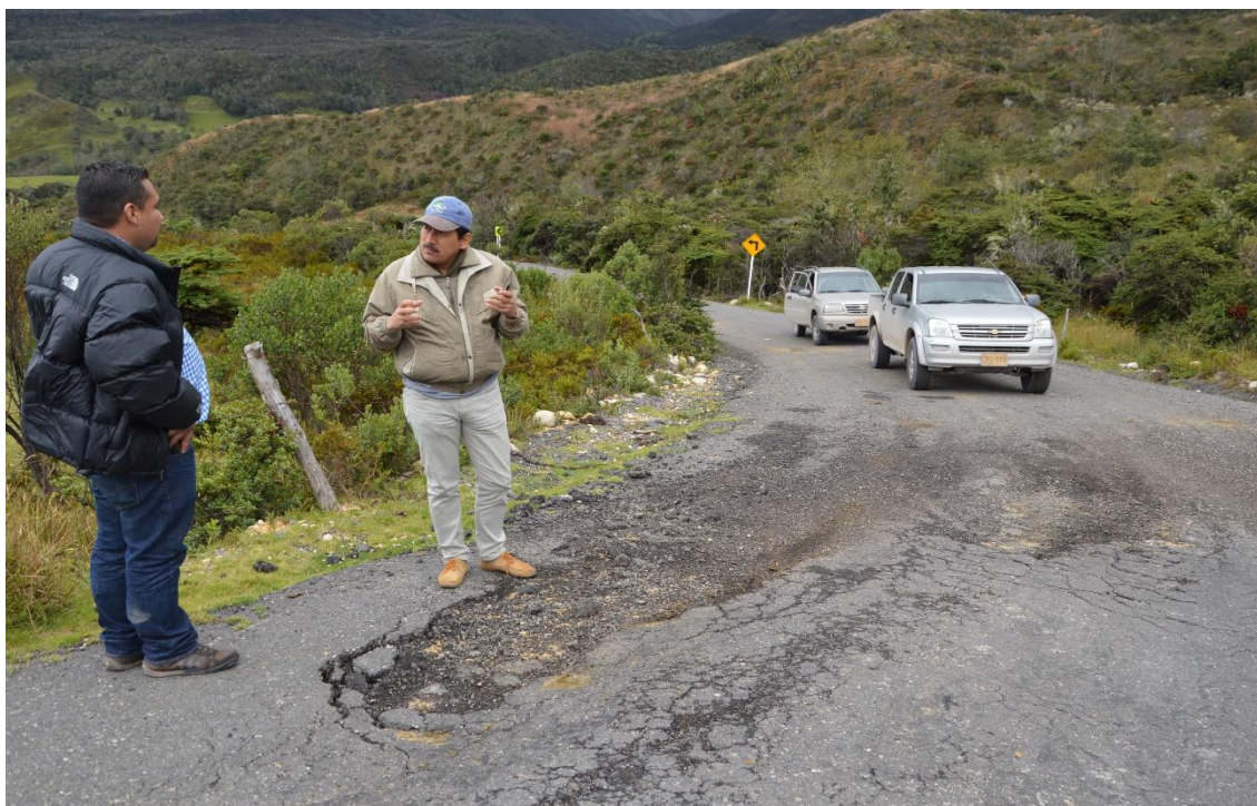
Verificación del deterioro - vías de la Localidad de Sumpaz
