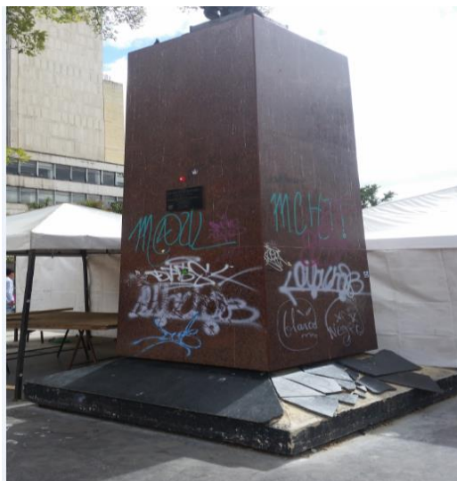
Acompañamiento en la localidad de Santa Fe, parque Santader con el objetivo de verificar una obra inoclusa y en un estado de deterioro de la misma.
